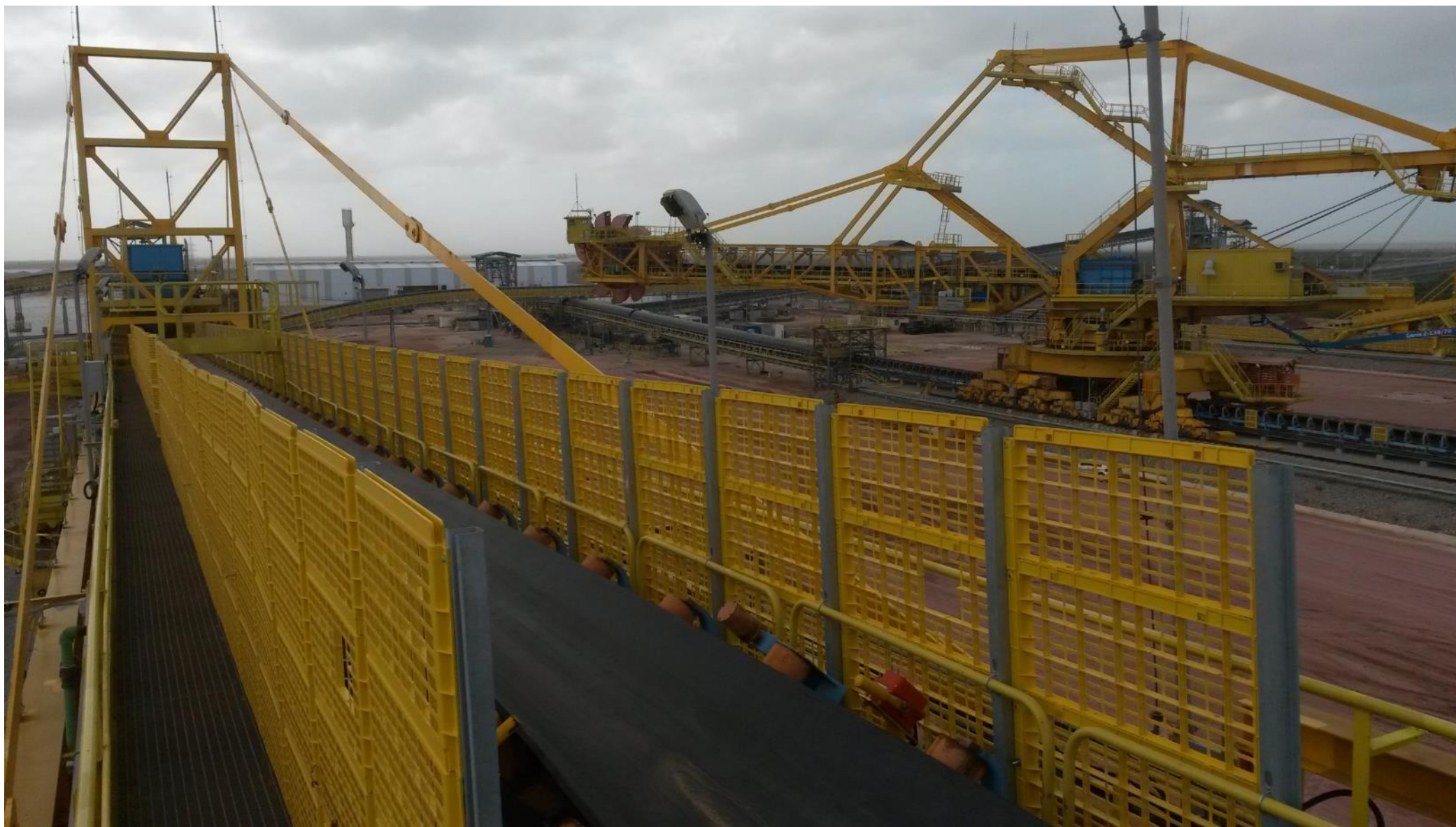
Vista geral da conclusão da montagem na lança da EP-01
