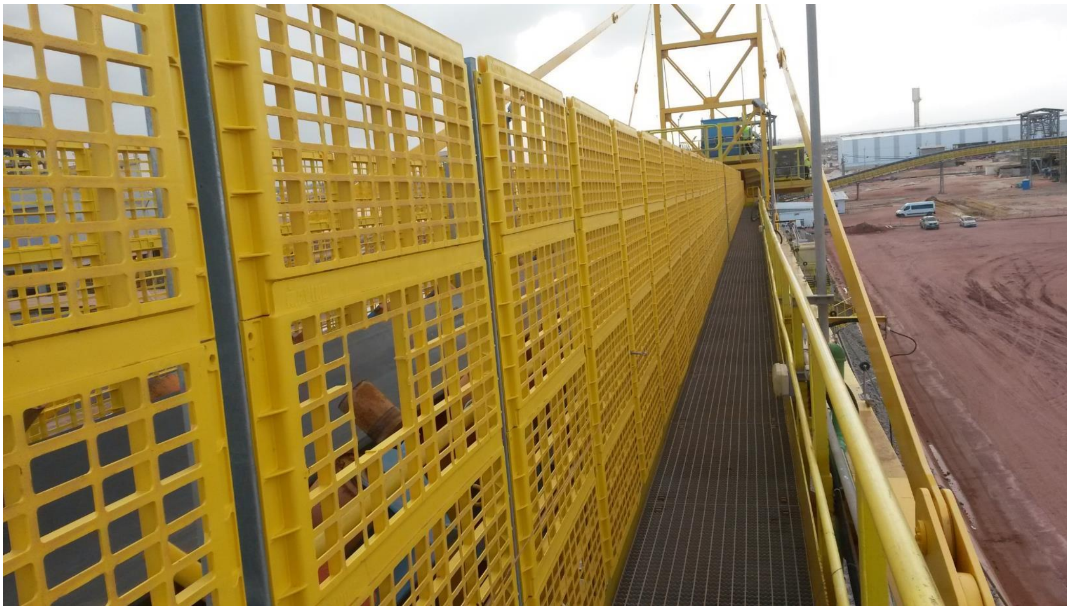
Conclusão da montagem de telas e cabo de emergência na lança da EP-01(Lado mar)
