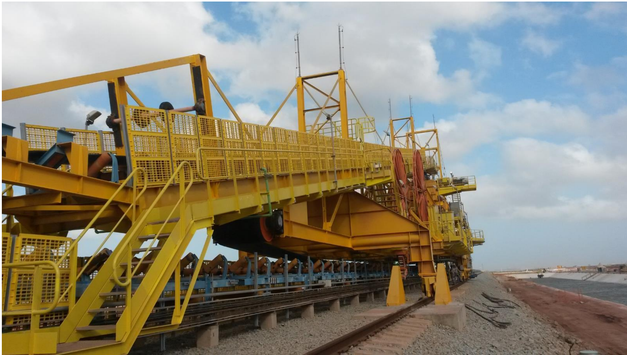
Vista geral da EP- 01 (Lado terra)
