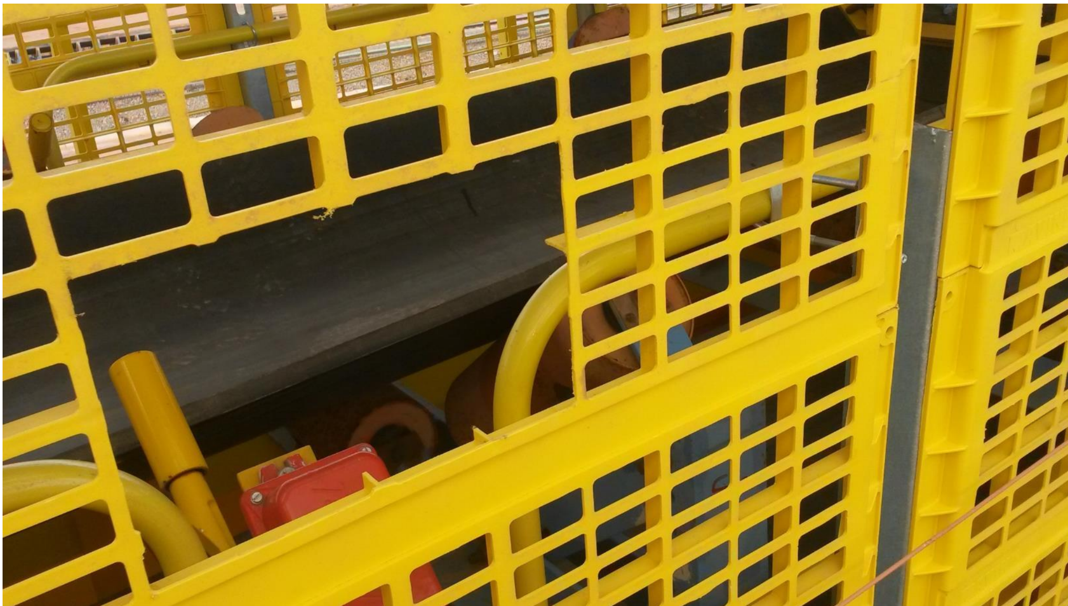
Detalhe do recorte das tela para acionamento da chave de emergência na lança da EP-01(Lado terra)
