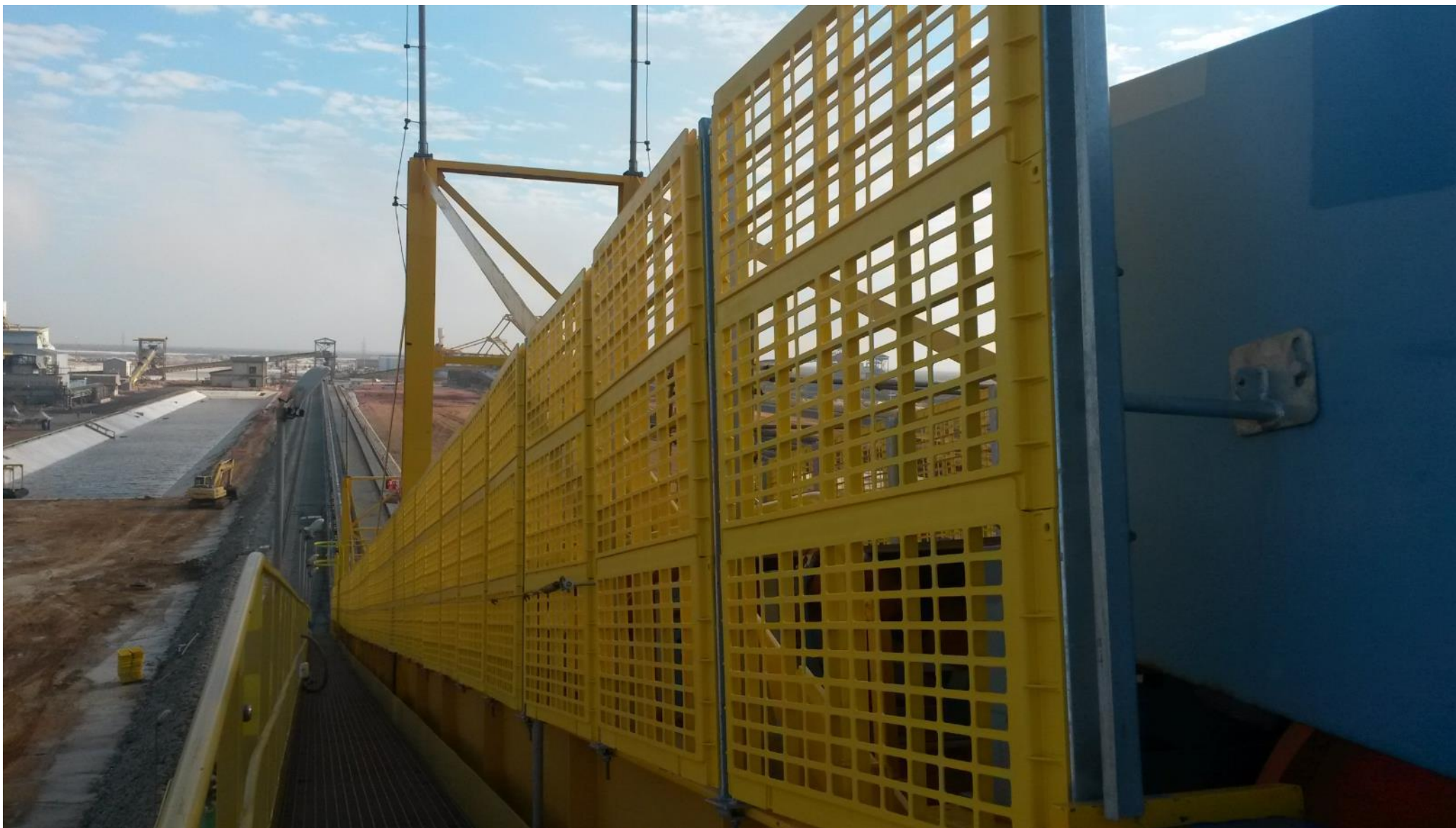
Conclusão da montagem de telas e cabo de emergência no tripper da EP-01(Lado terra)
