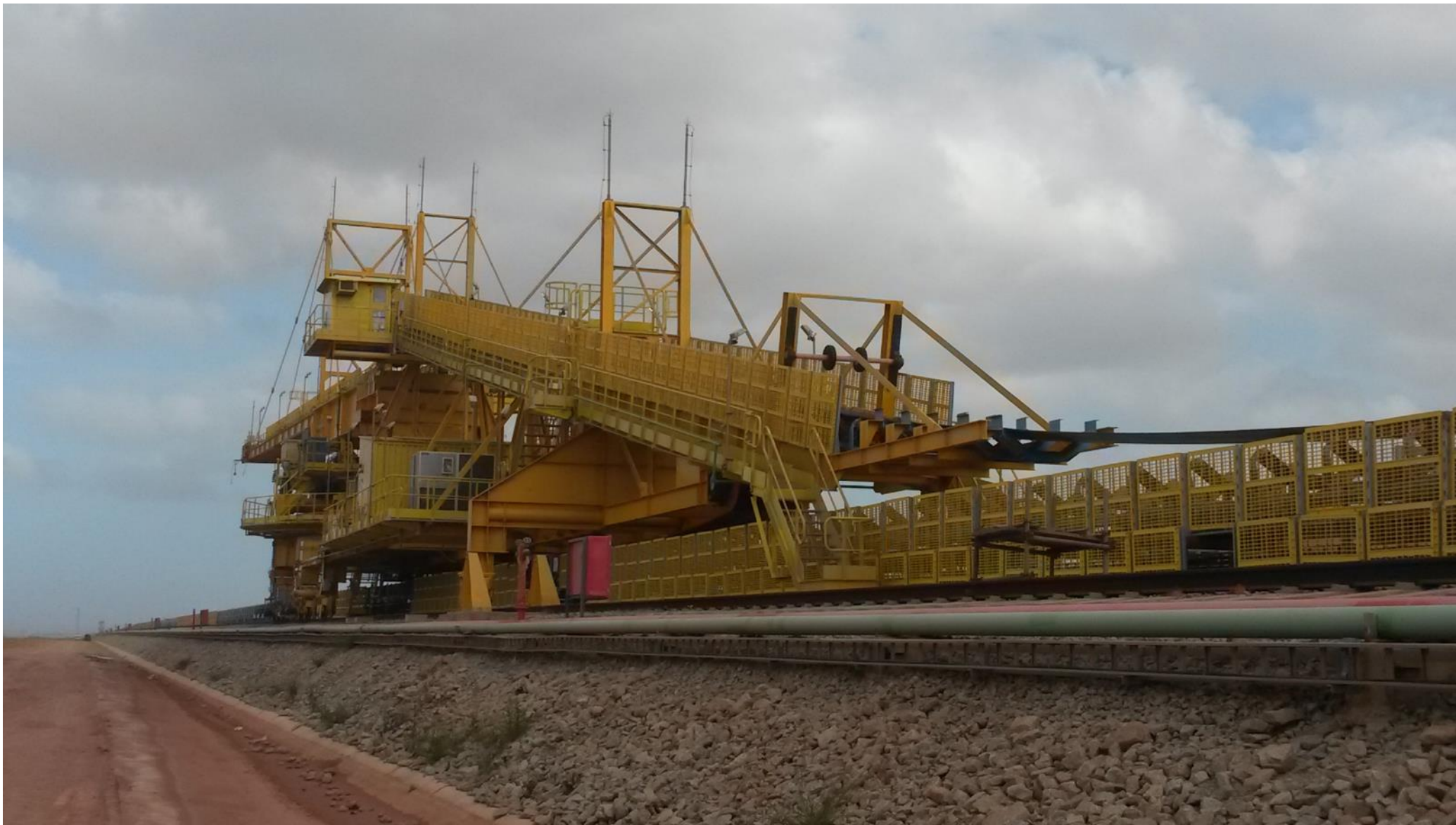
Vista geral da EP- 01 (Lado mar)
