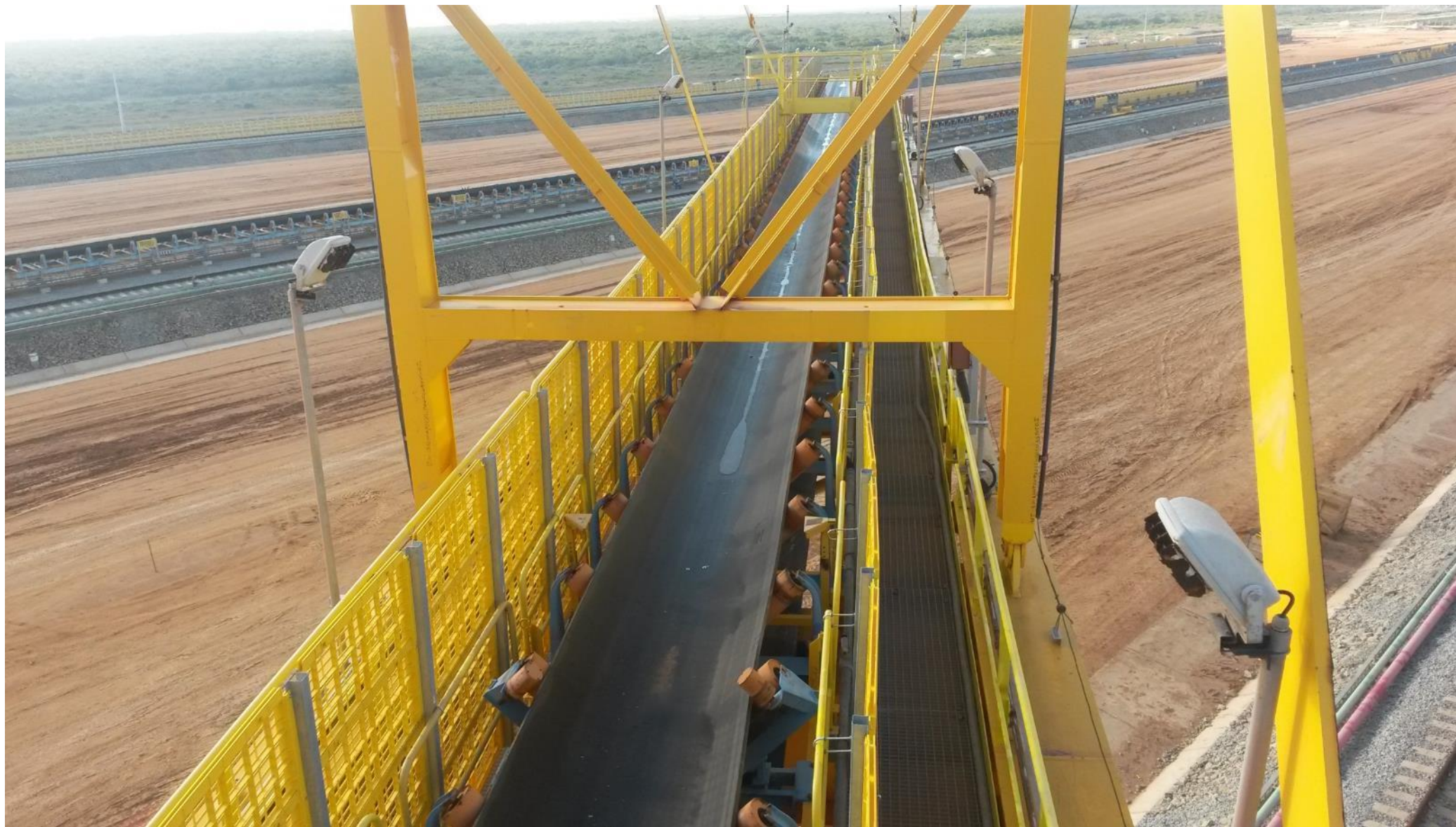
Conclusão da montagem de telas e cabo de emergência na lança da EP-01
