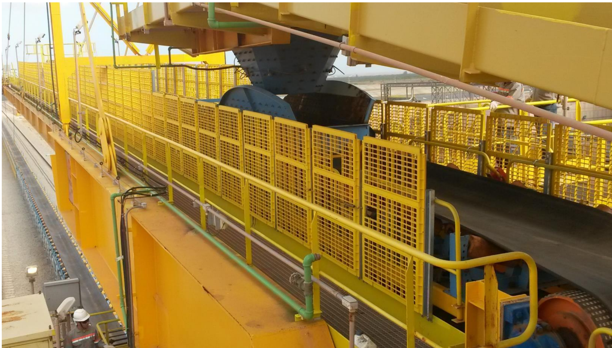
Conclusão da montagem de telas na lança da EP-01(Lado mar)
