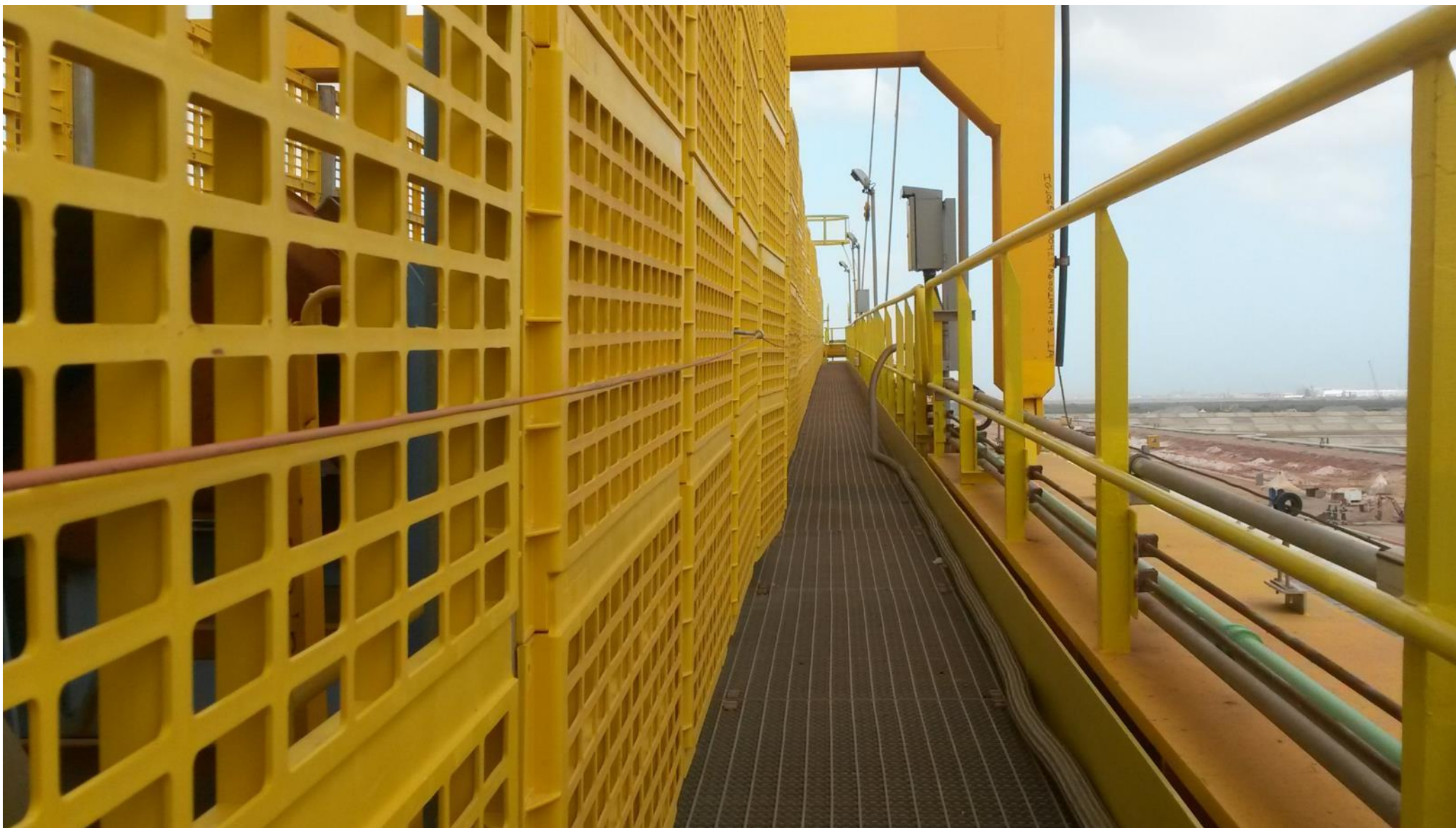
Conclusão da montagem de telas e cabo de emergência na lança da EP-01(Lado terra)
