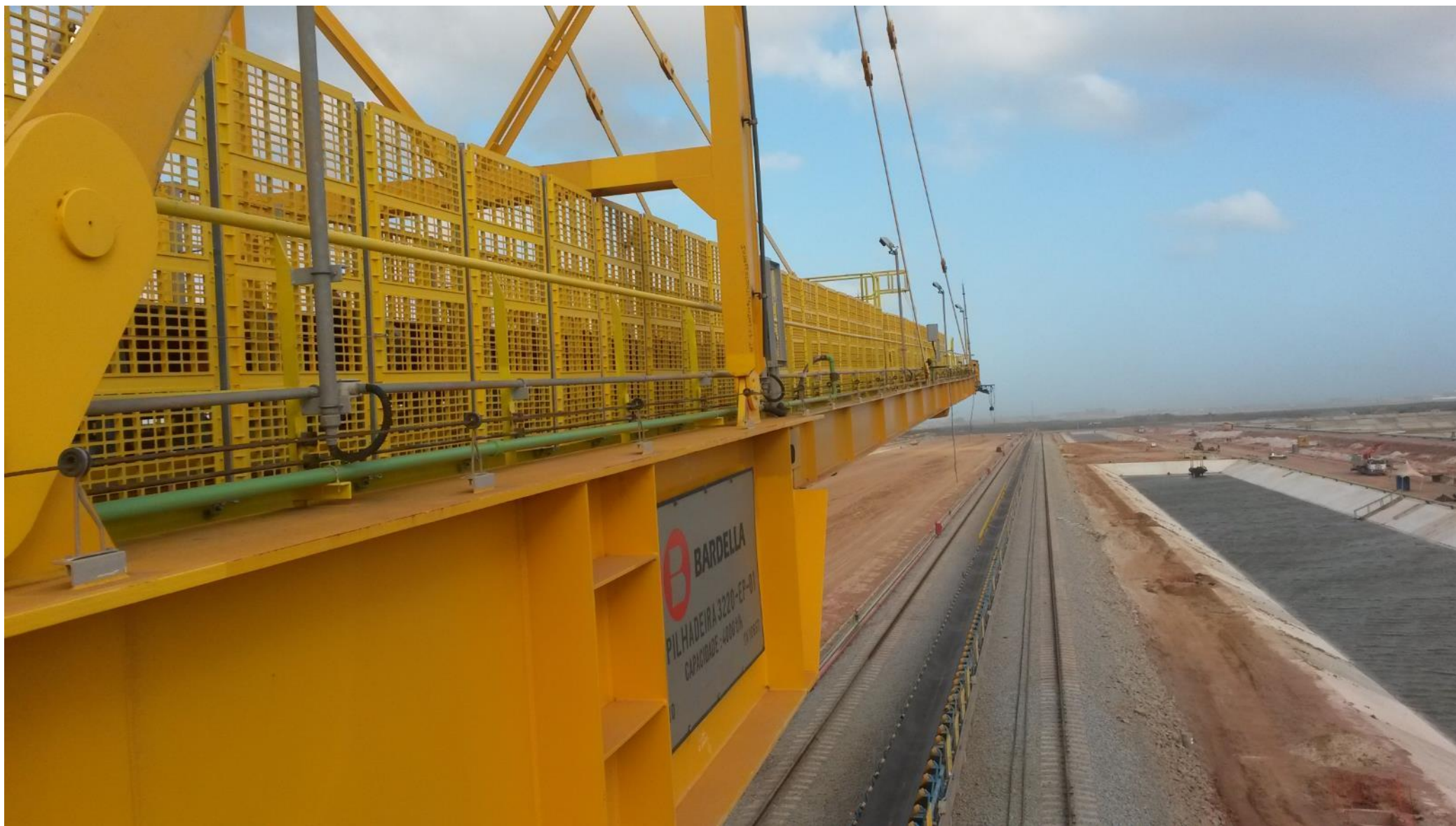
Conclusão da montagem de telas na lança da EP-01(Lado terra)
