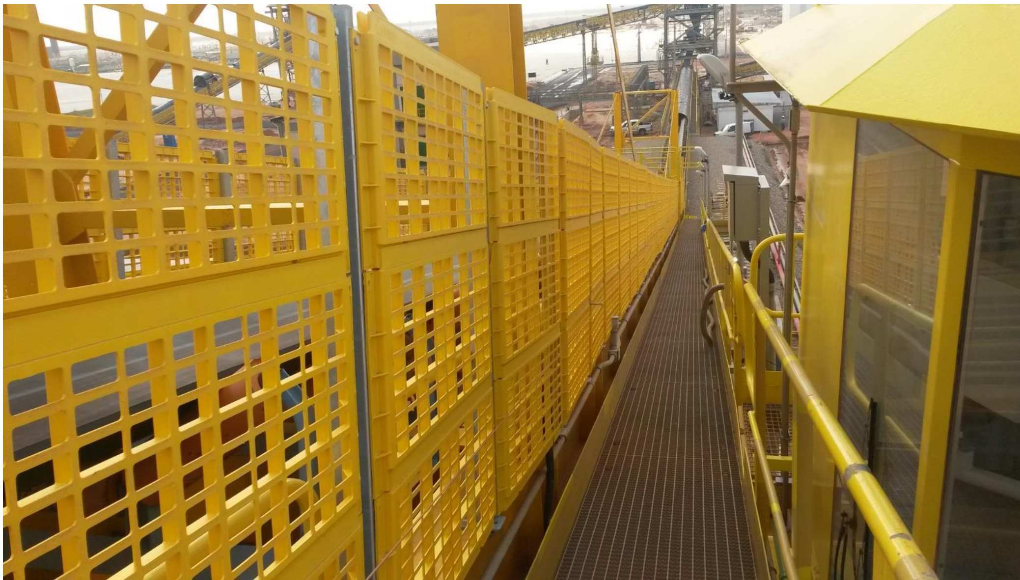
Conclusão da montagem de telas no tripper da EP-01(Lado mar)
