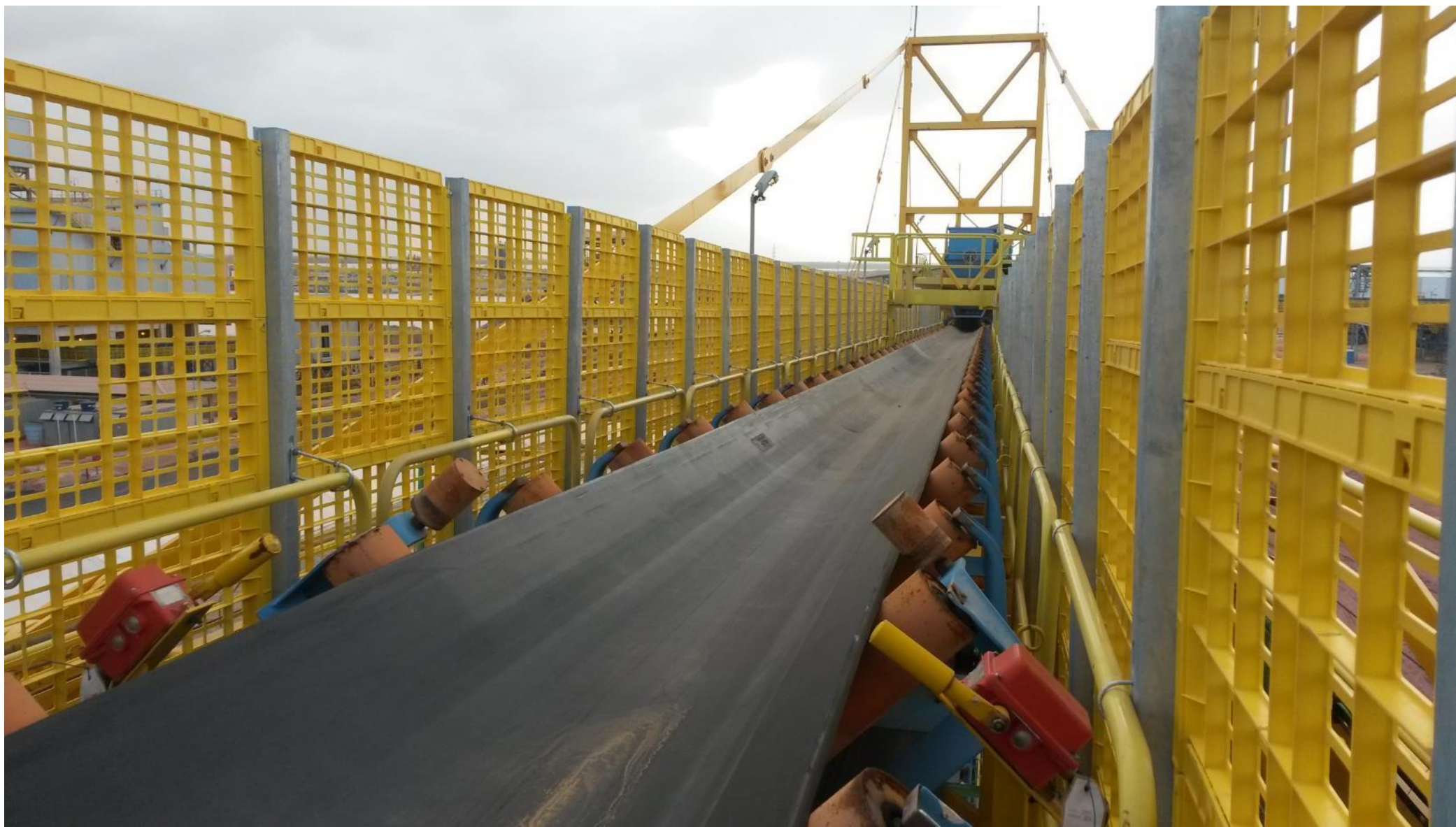
Conclusão da montagem de telas na lanca da EP-01
